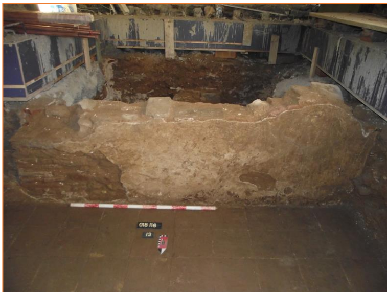
Foto 9. Detall del mur UE13 amb l'arrebossat que presentava pel costat nord.
