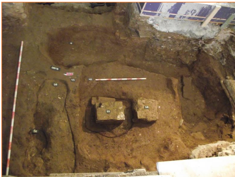
Foto 15. Vista general amb les estructures UE 54 i 55.
