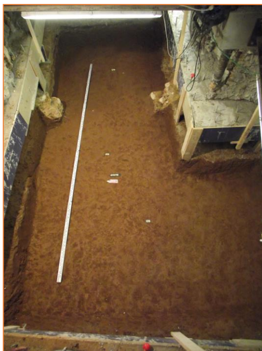
Foto 35. Detall final excavació amb el nivell d'argiles geològiques.
