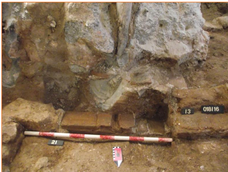
Foto 11. Detall de l'accés tapiat UE21 al mur UE13.
